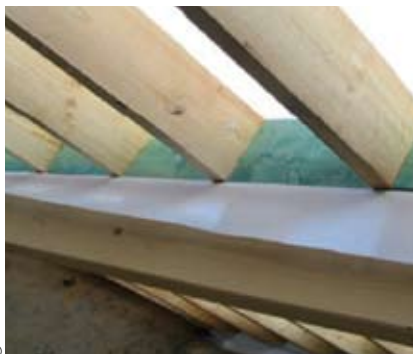
Afbeelding 3: PE-folie, aangebracht tijdens de plaatsing van het daktimmerwerk
