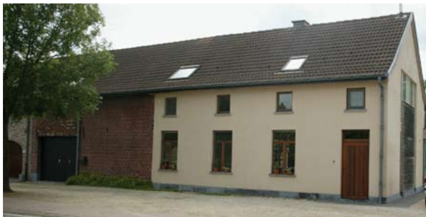
De sierpleister op de voorgevel maakt duidelijk welk deel van de woning in 2001 werd gerenoveerd. Plannen voor een gelijkaardige renovatie van het linkerdeel zijn opgemaakt.
