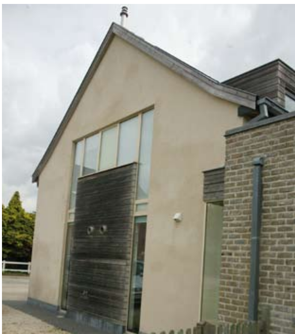
In de zijgevel kwam een lichtpartij met daarvoor een gevelbekleding in hittebehandeld hout, grenen dat door middel van een speciale behandeling een hoge duurzaamheid bezit.
