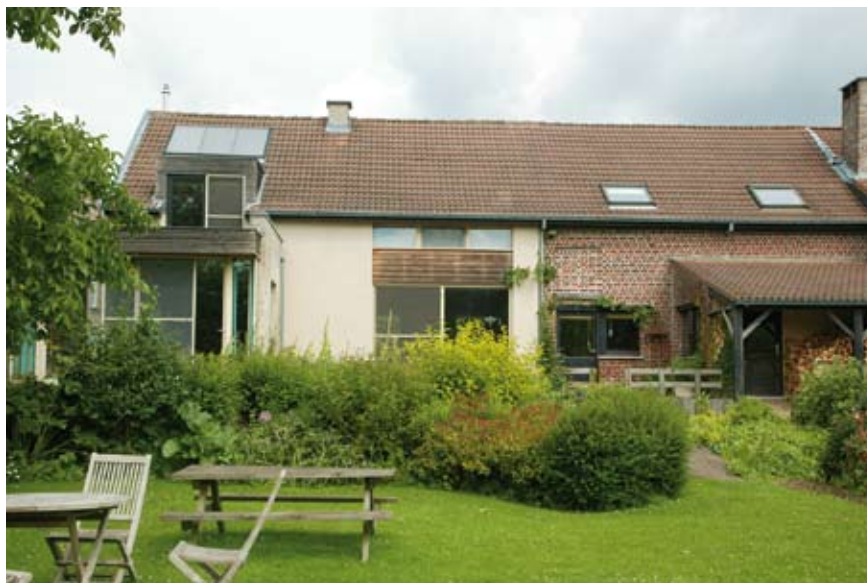
De zonnepanelen voor de zonneboiler beslaan 4 m 2 .
