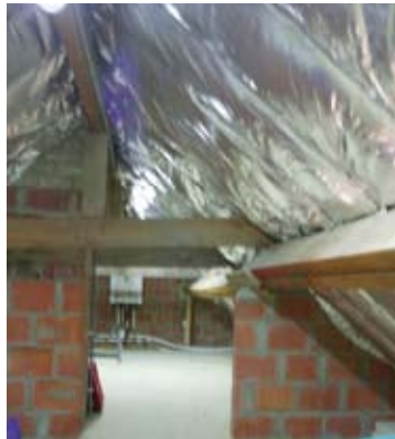
Onder de zoldervloer ligt 6 cm isolatiemateriaal, tussen het onderdak en de kepers 12 cm.
